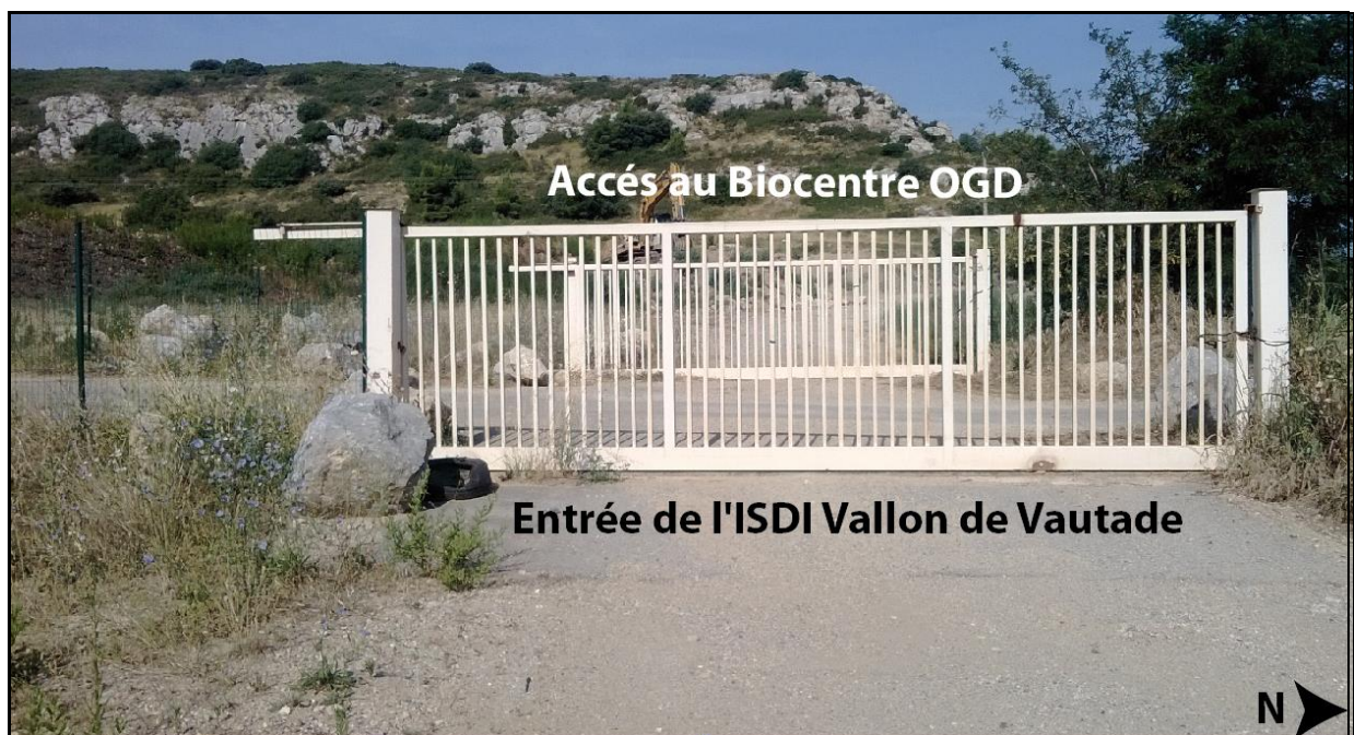
Figure 7 : Portails d'accès de l'ISDI du Vallon de Vautade et du Biocentre OGD
